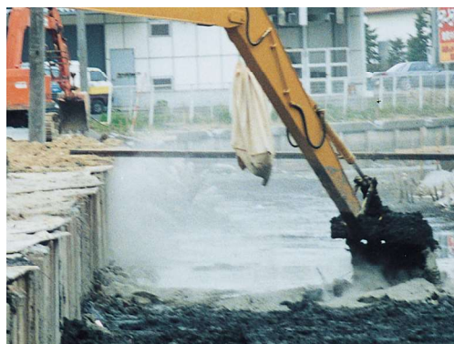
ミキシングフォーク作業現場
