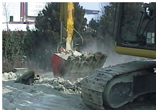
ドライブミキシング作業現場
